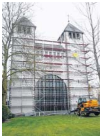
Eingerüstet: Das Äußere der Pfarrkirche Varensell wird in den nächsten Monaten saniert.
